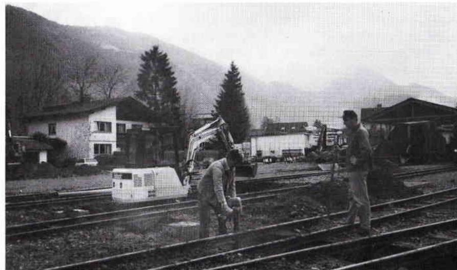
Noch am Montag wurden die Baugruben für den Wasserkran, für die große Aschengrube und die Drainageleitungen ausgehoben.
