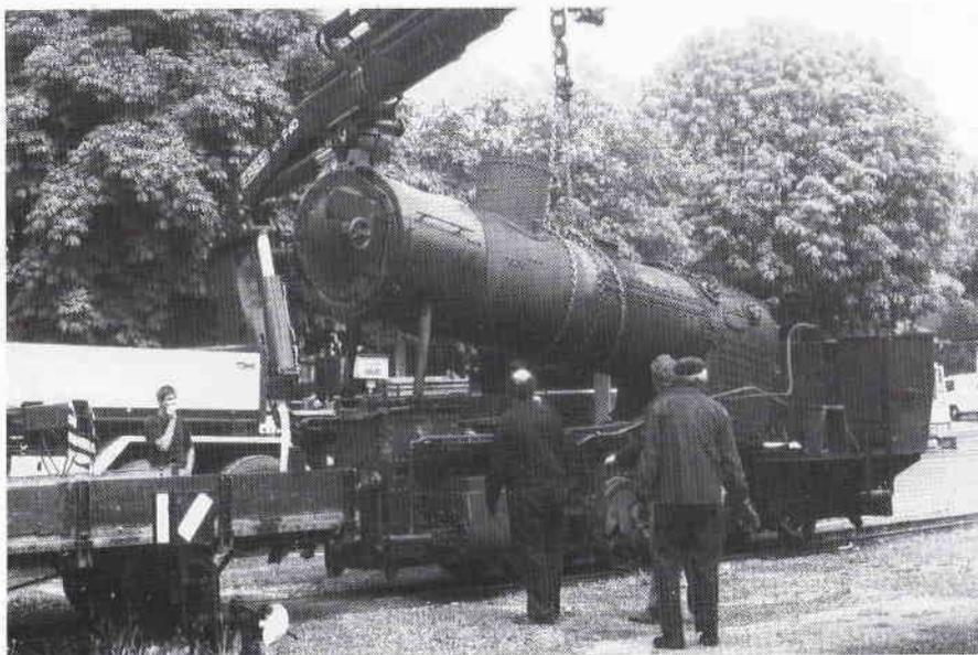
September 1995 - Dampflok Uh 3 ist kaum mehr zu erkennen; ein Mobilkran hebt den Kessel vom Fahrwerk ab (Foto DI Rolf Kubesch)
