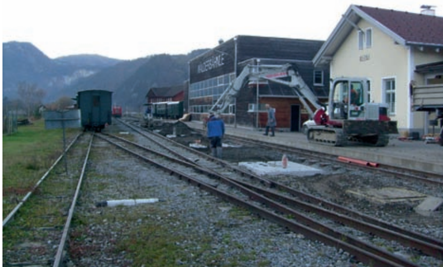
Bau der Betonfundamente für das neue Flugdach im November 2012
