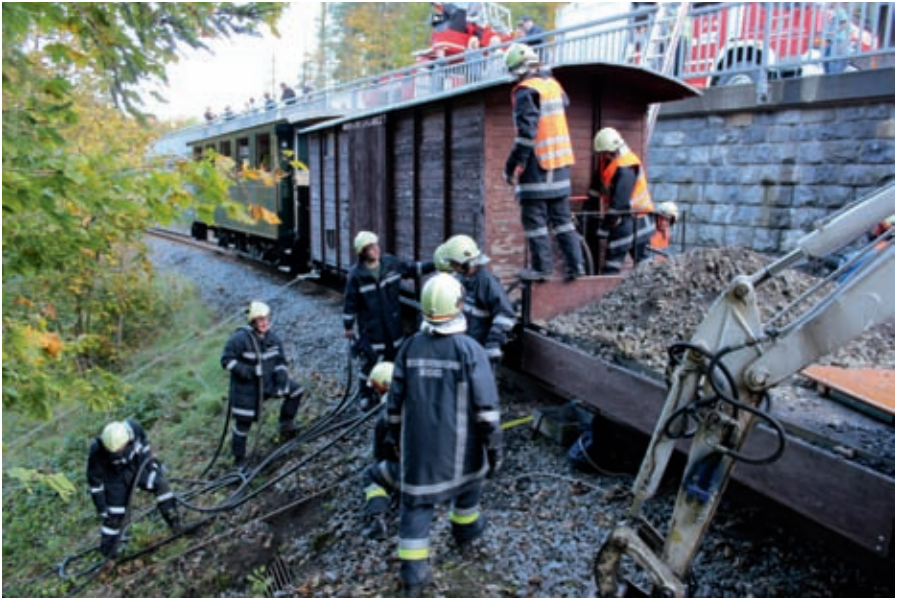
Untersützt durch die Drehleiter der Feuerwehr Andelsbuch als Personenkran bemühten sich die Einsatzkräfte um die Bergung der verletzten PKW-Insassen
