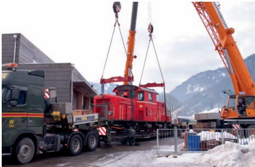
Am Morgen des 10. Jänner 2013 trafen 2 Mobilkräne aus Lustenau (Vorarlberg) in Bezau ein und hoben die Lokomotive auf das Spezialfahrzeug der Spedition Emil Egger in St. Gallen zum Transport in das rund 150 km entfernte Hinwil.
