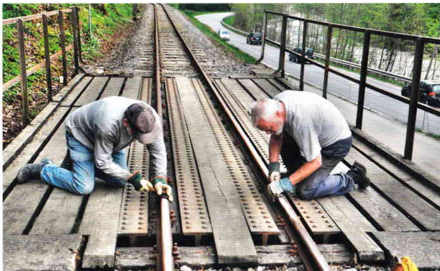
Martin und Rudl haben den klaren Auftrag zur Entrostung der Brückengeländer gründlich missverstanden und polierten stattdessen die Schienen.
