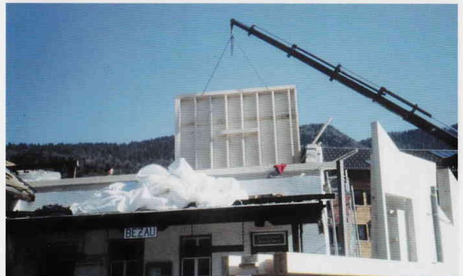
Die vorgefertigten Wandelemente für den Dachbodenausbau werden eingesetzt.
