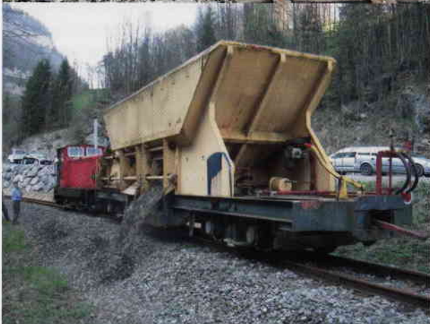
Anlieferung von Gleisschotter.
