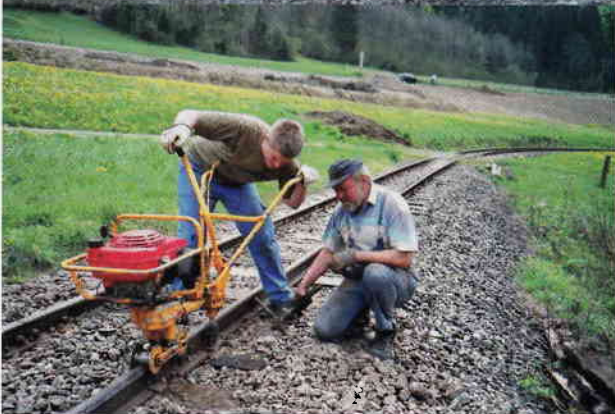
Befestigung neuer Schwellen mittels Schrauben an den Schienen.
