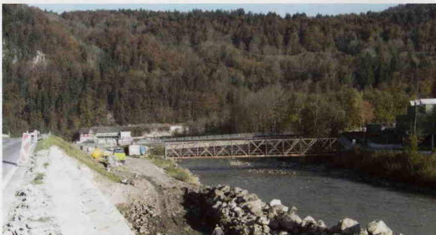
Der Ausbau der Bregenzerache ist schon bei der Bahnbrücke angekommen.
