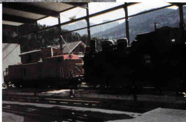
Die erste Belastungsprobe für die Gleiskonstruktion über den Montagegruben mit der 2091.08 und der Uh102
