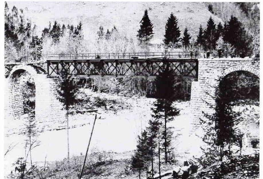
*Die Bregenzerache wird in km 31,73 mit einer Fachwerkbrücke überquert. Das Bauwerk kam bei einem Jahrhundert-Hochwasser zu Pfingsten 1999 zum Einsturz und wurde mit großem Einsatz für den Museumsbahnbetrieb wieder aufgebaut.
