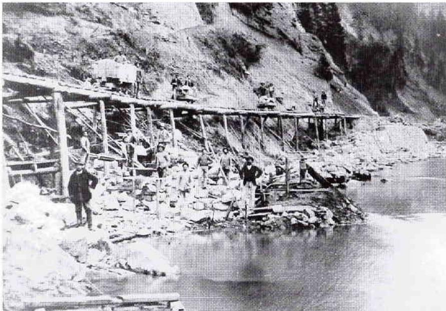
*Bahnbau in schwierigem Gelände.... Die Trassenführung im Achtal erforderte zum Schutz gegen Hochwasser und Hangrutschungen zahlreiche Ufer- und Stützmauern.
