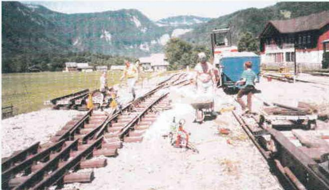
Durch den Einbau von zwei Weichen und dem ersten Stutzgleis war das zukünftige Ausmaß des Flugdaches absehbar. (Foto: A. Arnegger)
