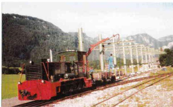
Für den Stahlbau sind Teile einer demontierten Halle aus Deutschland und als Ergänzung dazu, neue Stahlprofile eingesetzt worden. Im Bild Mitarbeiter der Fa. Meusburger-Fahrzeugbau bei der Befestigung der letzten Querträger. (Foto: F. Meusburger)
