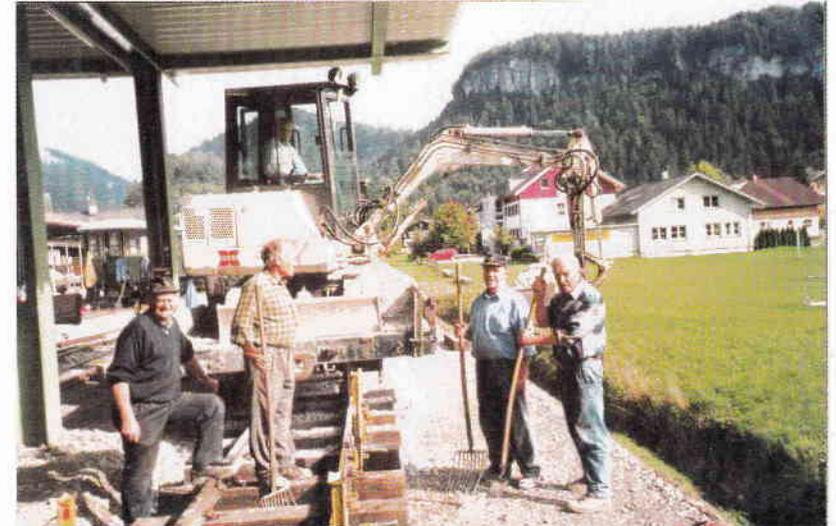
Ab 10. September haben Vereinsmitglieder in einer kurzfristig angesetzten Arbeitswoche das zweite Stutzgleis und den Anschluss an die in den Vorjahren bereits verlegte Weiche hergestellt. Die Installation für Licht und ausreichend Steckdosen erforderte eine 110 m lange Zuleitung zur Stromversorgung und viele Stunden an Montagearbeiten in luftiger Höhe. (Foto: F. Meusburger)
