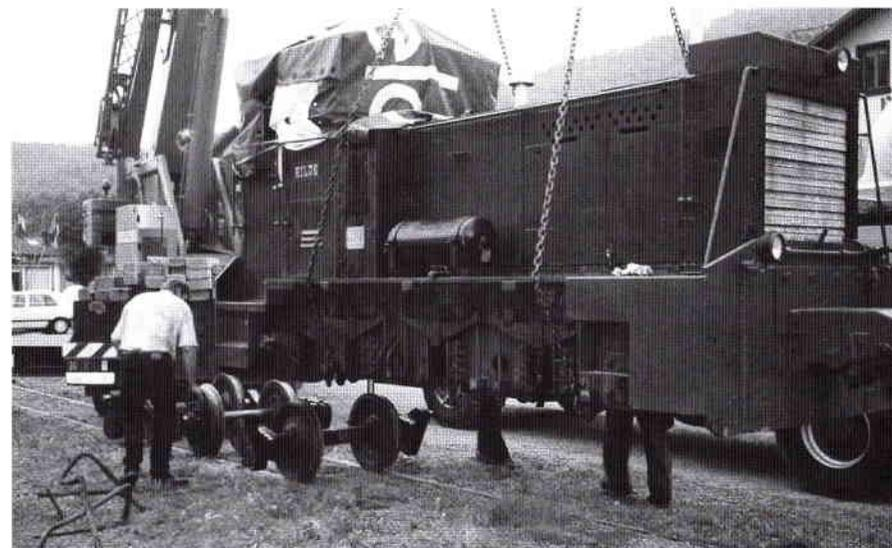
Im Anschluß an die Verladung der Dampflokomotive Uh 102 mittels Tele-Kran wurde die Gelegenheit genutzt und auch die Diesellok "Hilde" soweit angehoben, um die Achsen ausbauen zu können. (Foto: R. Feurstein)
