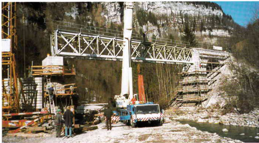
Am 21. und 22. März 2000 wird das alte Tragwerk eingehoben. Dazu war eine Plattform in der Mitte des Flußbettes notwendig. Um den Termin für die Inbetriebnahme der Brücke nicht zu gefährden, wurde das Tragwerk eingehoben, obwohl der letzte Deckanstrich nur teilweise fertiggestellt war. Die restlichen Anstricharbeiten wurden in luftiger Höhe durchgeführt. (Foto: Rober Feurstein)
