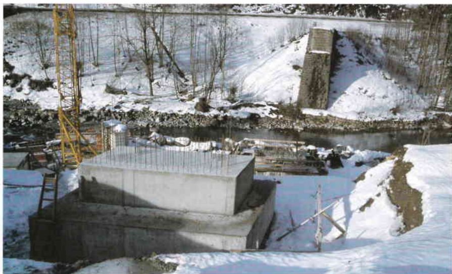
Herstellung des Fundamentes für das neue Widerlager auf der Bezauer Seite. Selten lag die Baustelle im Sonnenschein, meistens herrschten Temperaturen bis -20^{\circ}\text{C} (Foto: Walter Rabanser)
