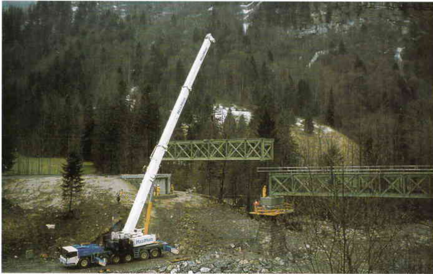
Noch am 13. April 2000 wird das neue Tragwerk eingehoben. Die Baufläche in der Bregenzerach wurde bereits zurückgebaut und um den neuen Pfeiler eine starke Vorgrundsicherung gezogen. (Foto: Walter Rabanser)
