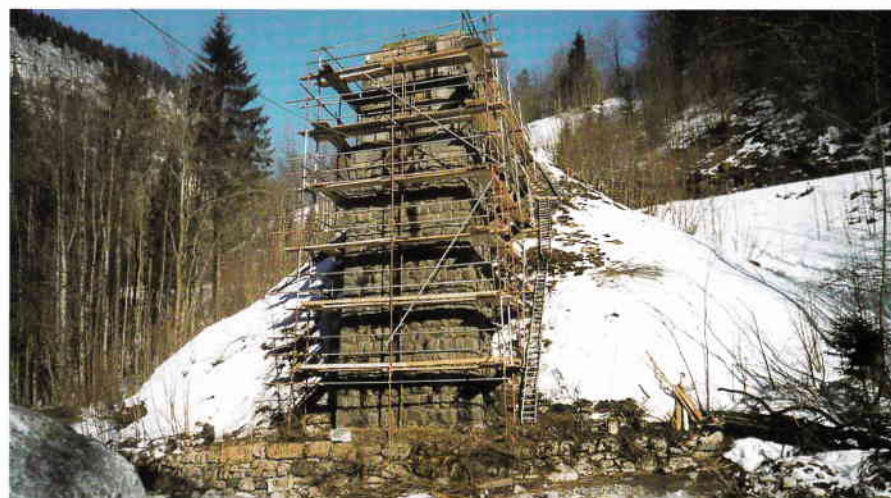
Ende Februar wurde mit der Sanierung des Andelsbucher Widerlagers begonnen. Die Fugen wurden zur Gänze erneuert und die losen Lagerquader befestigt. Außerdem mußte am Randbalken ein Stein (im Eck links) aus der Bregenzerach gehoben und wieder montiert werden. (Foto: Jakob Bobleter)
