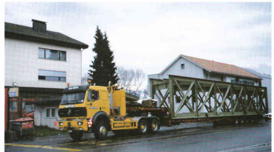
Das neue 20,80 m lange Tragwerk wird aus der Schweiz antransportiert. Es wurde im Werk zusammengebaut. Einzig die Geländer mussten noch am Einbauort montiert werden. Das Bild zeigt den Sondertransport am 12. April 2000 in Höchst unmittelbar nach dem Grenzübergang. (Foto: Walter Rabanser)
