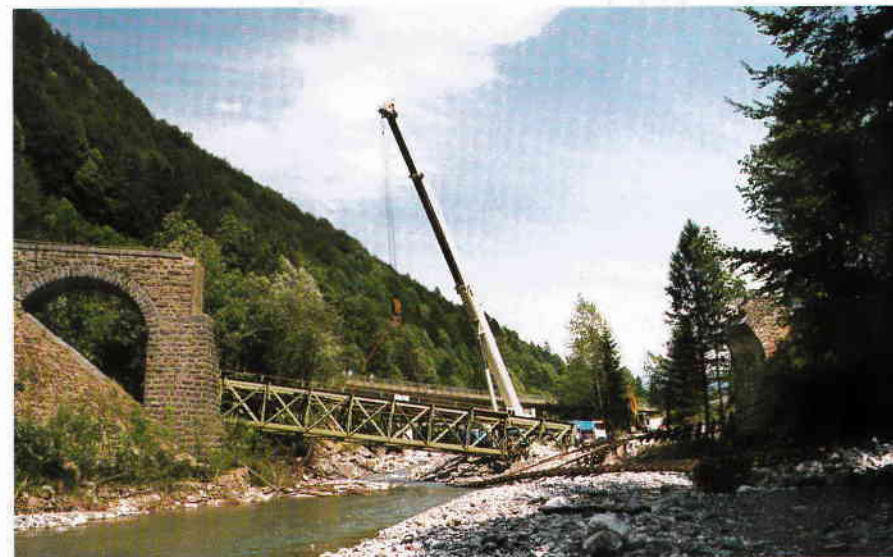
Am 5. und 6. Juli ist das alte Tragwerk von einem Telekran auf einen neben der Baustelle geschütteten Platz gehoben. Der Böschungskegel auf der anderen Seite wurde vom Hochwasser verschont. Der gleiche Kegel war auch auf der Bezauber Seite vorhanden. Man erkennt, daß die Ache diesen komplett weggerissen hat. (Foto: Werner Kohler)
