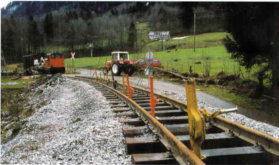
Schon vor dem Antransport des neuen Tragwerks wurde mit der Herstellung des Oberbaues in den Anschlußbereichen begonnen. Hier ist im Bogen auf der Seite Bezaug der Gleisrost bereits verlegt und wird höhenmäßig eingerichtet. (Foto: Hans Christian Ettengruber)
