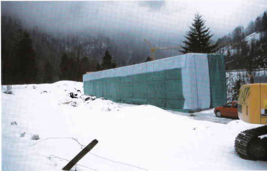
Unterdessen wurde das alte Tragwerk eingerüstet, mit einer Plane abgedeckt und damit ein beheizbarer Raum geschaffen. So konnten die Anstricharbeiten planungsgemäß durchgeführt werden. (Foto: Walter Rabanser)
