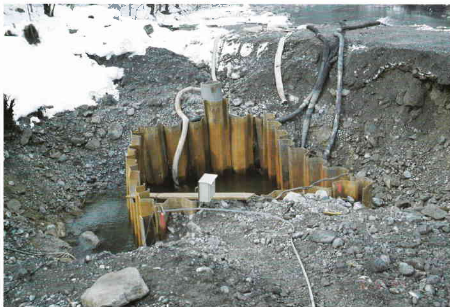
Im November 1999 wurde zur Fundierung des neuen Pfeilers eine 5 m tiefe Spundwand abgeteuft. (Foto: Walter Rabanser)
