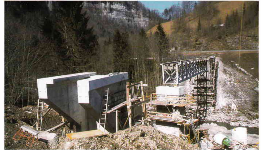
Beim Widerlager Bezauf sind die Stahlbetonarbeiten abgeschlossen. Auch die Natursteinverkleidung ist bereits zum großen Teil fertiggestellt. Gut zu erkennen ist die Konstruktion des Tragwerkes mit der versenkten Fahrbahn. (Foto: Walter Rabanser)
