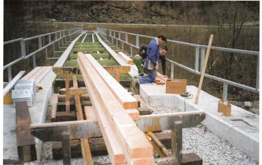
Auf dem Tragwerk sind die Geländer montiert und es wird mit der Bedielung begonnen. Der Knick zwischen dem alten und neuen Tragwerk kommt daher, weil das neue Tragwerk bereits im Übergangsbogen liegt. (Foto: Robert Feurstein)
