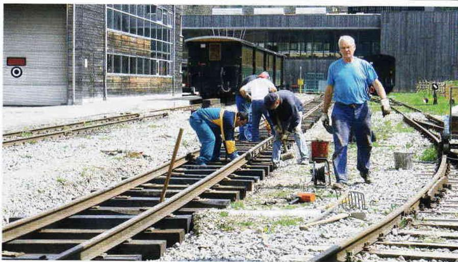
Das Schotter/Dreckgemisch wurde durch eine Baufirma ausgehoben und - im Austausch - mit neuem Gleisschotter ersetzt. Zeitgerecht stand den Kollegen danach ein gewalztes Unterplanum zur Verfügung, auf das sie 130 neue Schwellen auslegten.
