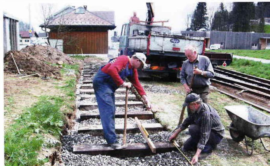
**Der Gleisbau am Bf. Schwarzenberg wurde von Kurt mit seinem LKW-Kran unterstützt**
